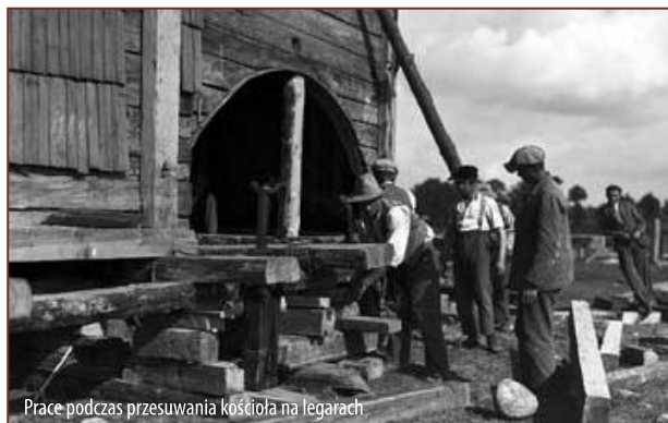
Prace podczas przesuwania kościoła na legarach
