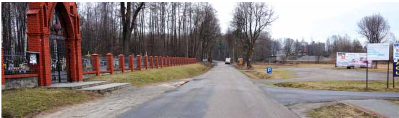
Droga w Skrzyszowie gdzie zostanie wykonany chodnik
