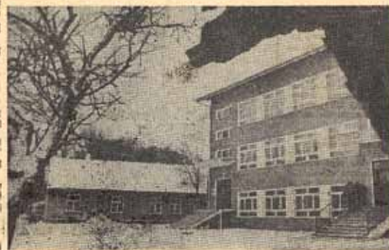
Z lewej – stara szkoła. Z prawej – „po remoncie”.
